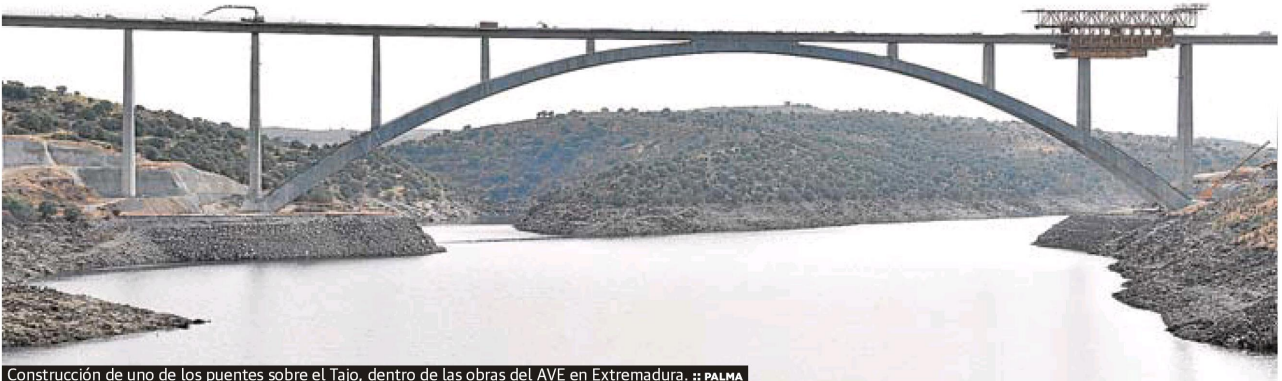
Construcción de uno de los puentes sobre el Tajo, dentro de las obras del AVE en Extremadura. :: PALMA
